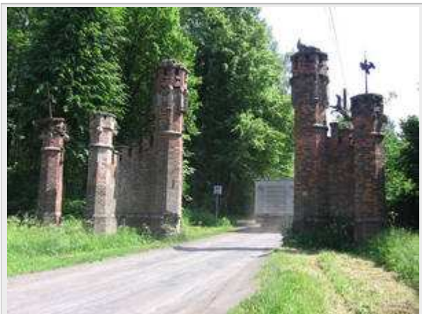
Zabytkowa Brama Zwierzyniecka niszczona jest przez przejeżdżające przez nią tiry
